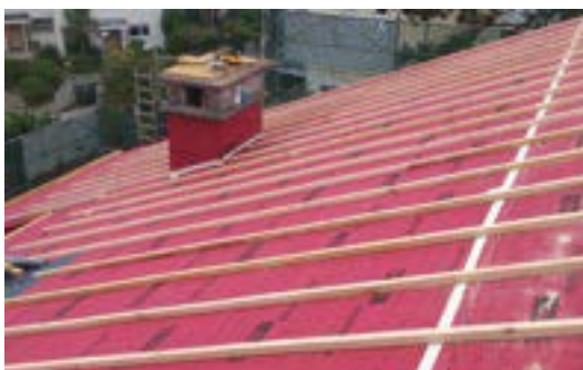
Figure 21: Sous-couverture en lé
