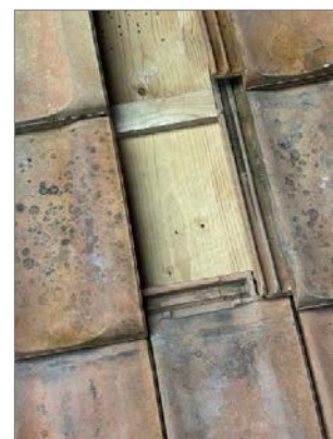
Figure 3 : Dépose de la couverture
