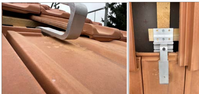
Figure 6 : Les rainures d'emboîtement en tête de la tuile doivent être fraisées au moyen de la meule à disque et taillées à la marteline. La distance entre le bas du crochet et le matériau de couverture doit être d'environ 5 mm.
