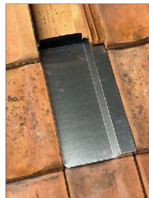
Figure 4 : Pose de la tuile en tôle et du joint d'étanchéité, montage du crochet pour panneau photovoltaïque
