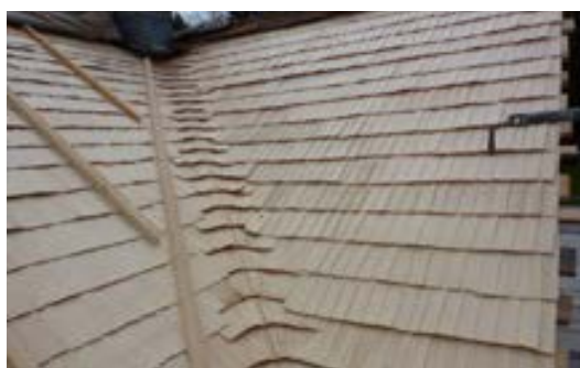
Figure 22: Sous-couverture en tavillons
