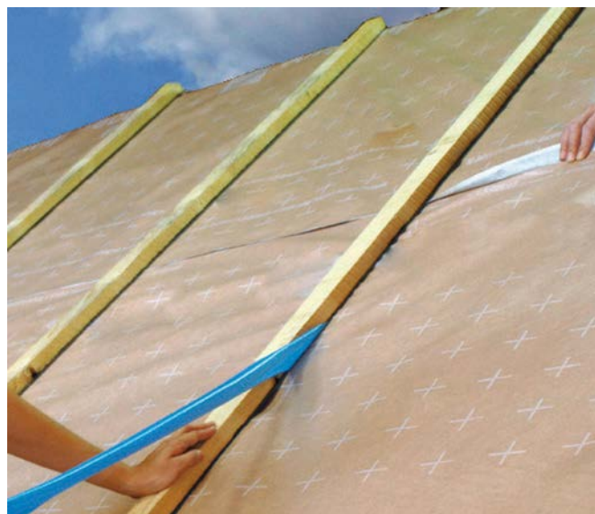
Figure 16: Ruban d'étanchéité sur toute la longueur de la contre-latte pour rendre étanches les fixations traversantes
