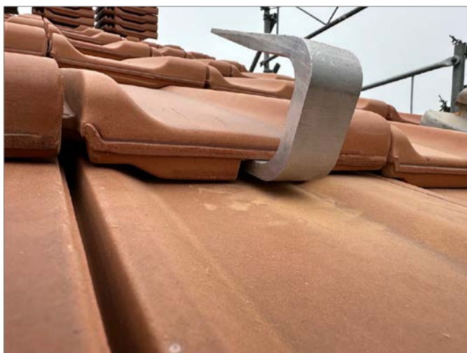
Figure 7 : Le nez de la tuile doit également être découpé à la meule et soigneusement rogné à la marteline.
