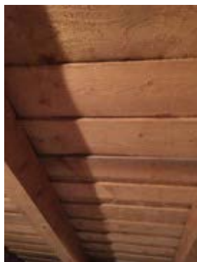
Figure 20: Lambris de bois posé à recouvrement.
