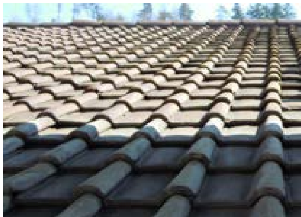
Figure 10: Bon état sans dégât dû au gel. Pour ce type de couverture, il est envisageable de prévoir une installation solaire pour autant que la sous-structure réponde aux exigences.
