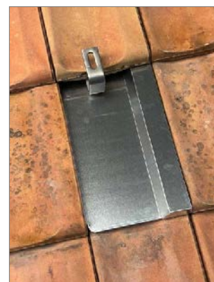
Figure 5 : Repose de la couverture
